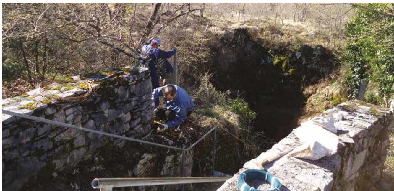
Urejanje vhodnega dela v jamo.
